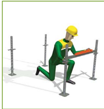
> 1- Implantation et pose des traverses basses sur les vérins de pied.
