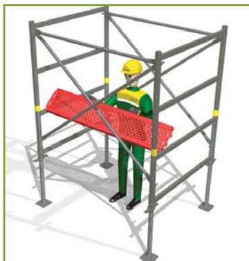
> 6 - Installation des 2 planchons à 1m sous les lisses garde-corps.
