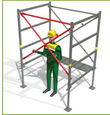
> 4 - Mise en place des croisillons de sécurité .
