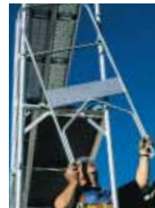
Pose des garde-corps de montage et d'exploitation latéraux,
