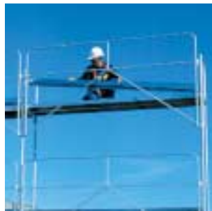
pose des plinthes.
