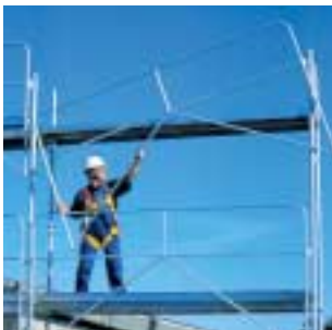
Pose des garde-corps de montage et d'exploitation longitudinaux,
