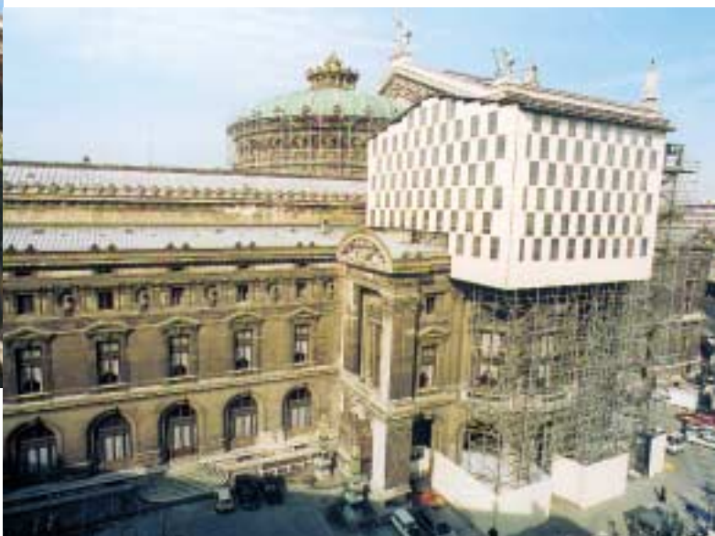
Parapluie pour travaux de rénovation de l'Opéra Garnier à Paris.
