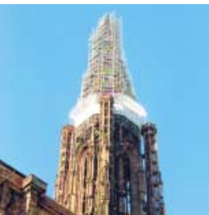
Restauration de la cathédrale de Strasbourg.
