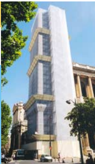
Parapluie pour travaux de rénovation de l'Opéra Garnier à Paris.
