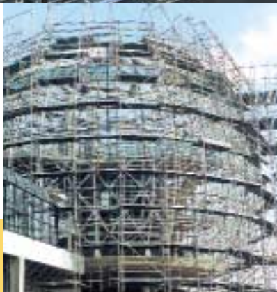
Échafaudages de services Le MultiCrab, multidirectionnel, permet la réalisation d'ossatures courbes.
