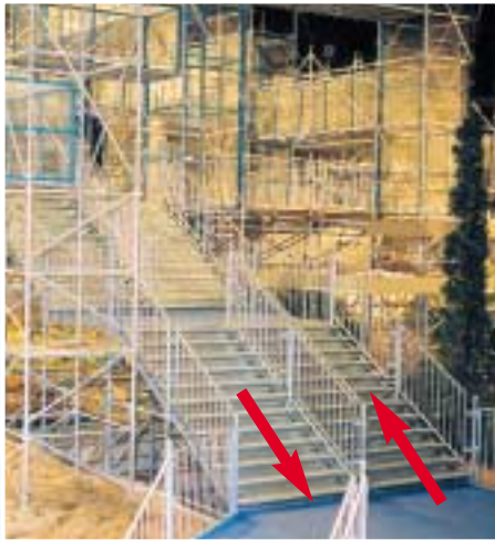
Escaliers à double sens de circulation
